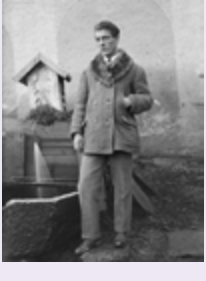
56438N Bauarbeiter Lambrechterhof, o. D.
